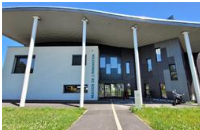
Maison de l'Innovation - Campus des Cézeaux
