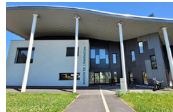
Maison de l'Innovation - Campus des Cézeaux
