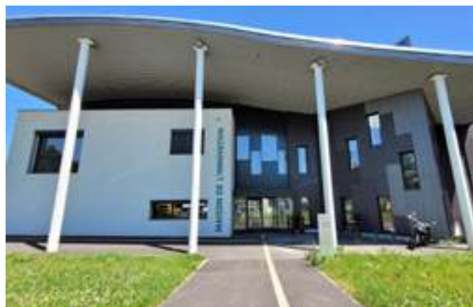
Maison de l'Innovation - Campus des Cézeaux
